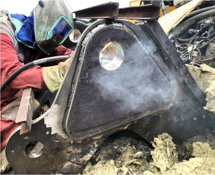
Zavarivanje oštećenih uški za prihvat grane
