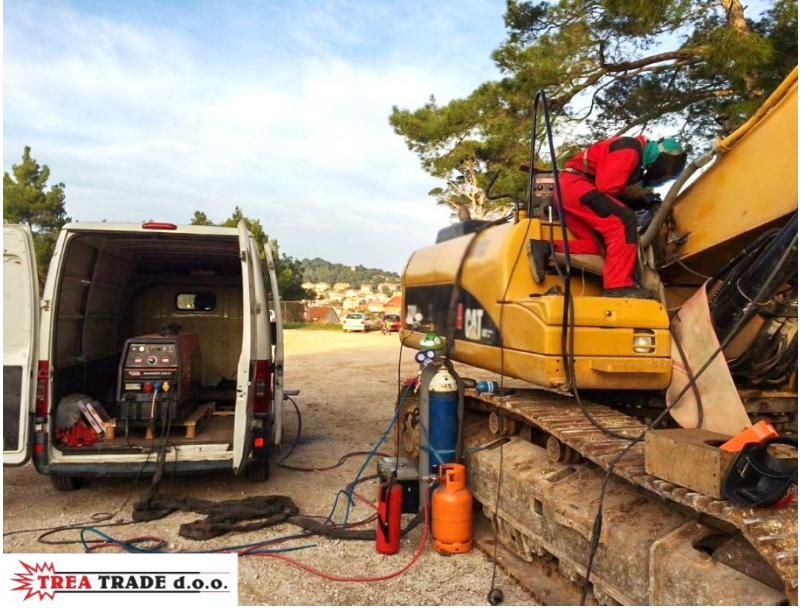
Sanacija pukotina na donjem dijelu prihvata grane
