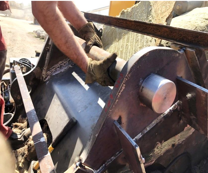
Zamjena oštećenih uški za prihvat grane
