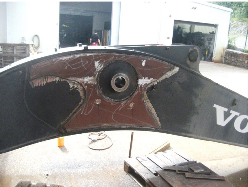
Ugradnja pojačanja oko prihvata hidrauličnih cilindara
