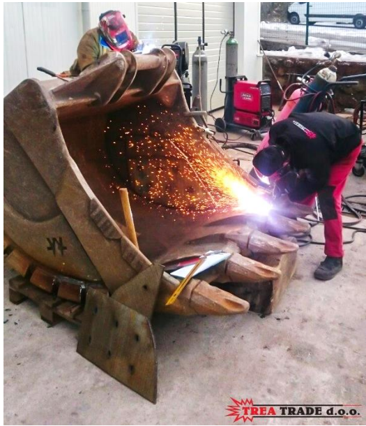
Sanacija pukotina na korpi
