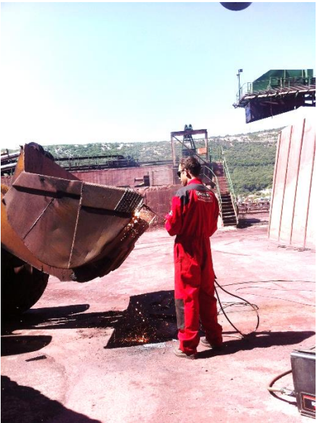
Sanacija noža korpe utovarivača
