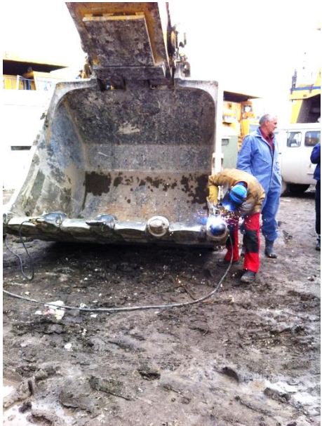
Sanacija pukotine korjena zuba
