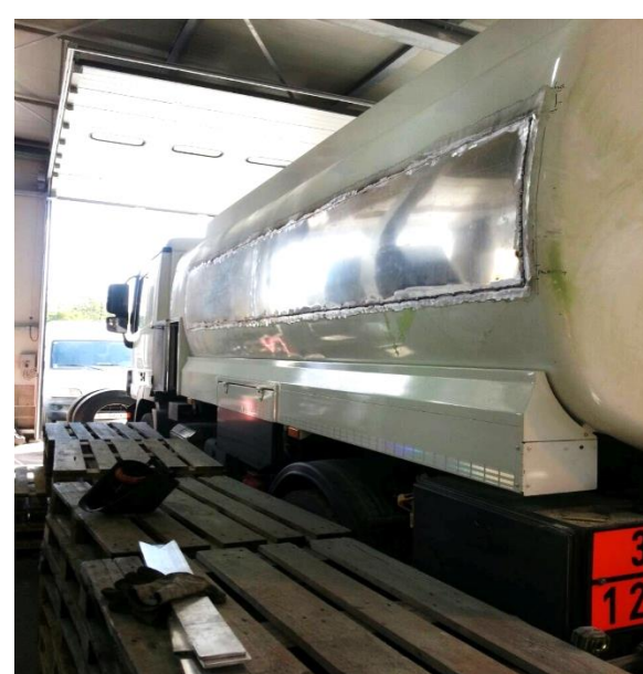
Zavarivanje pojačanja na al. cisterni
