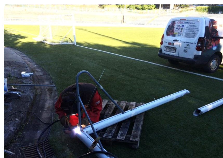
Zavarivanje al. golova na terenu
